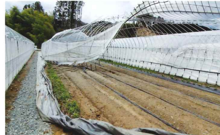
▲台風で吹き飛ばされたハウス
