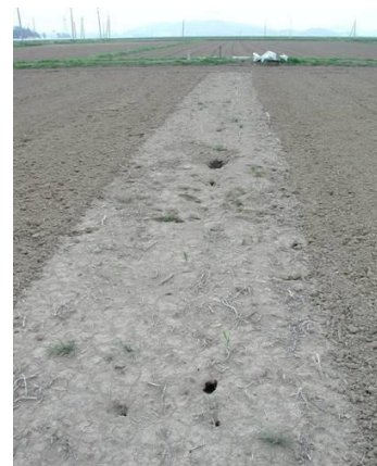
空洞化による田面の陥没
