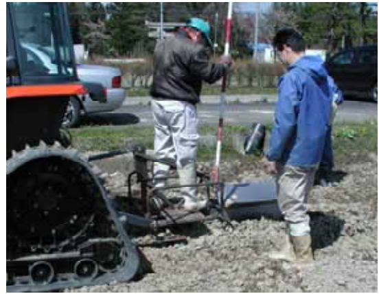
切削部の差し込み
