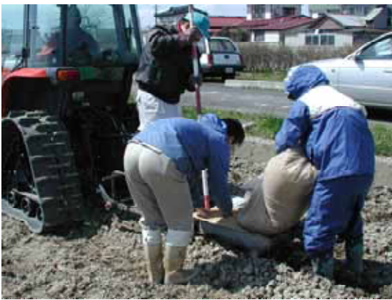
籾殻投入・突き固め
